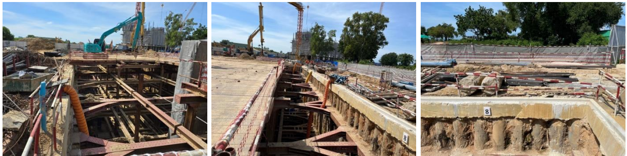
รูปที่ 2.2-4 ระบบป้องกันดินพัง แบบ Sheet Pile ร่วมกับคาน และเสาเหล็ก (ช่วงงานฐานราก)
